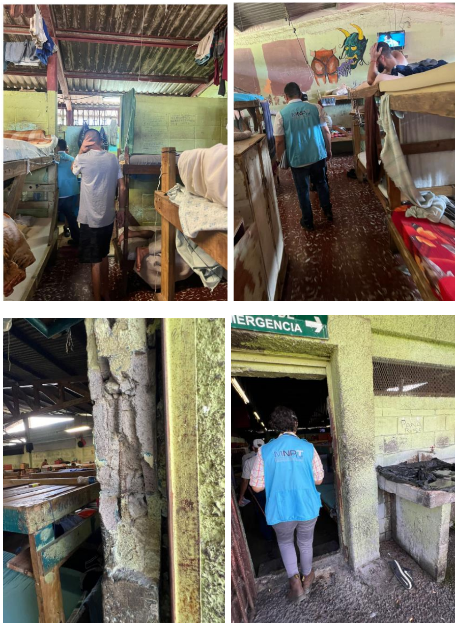
Fotos: pasillo y puertas de acceso a módulos.
