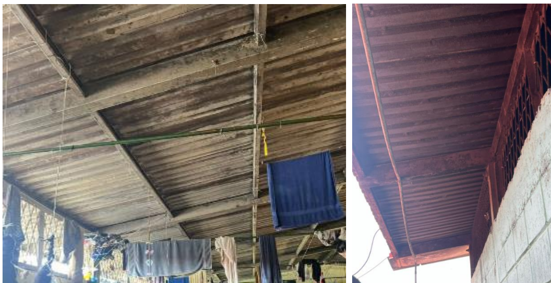
Fotos: Parte externa del módulo con la estructura del techo y de la rejilla de ventilación con corrosión.
